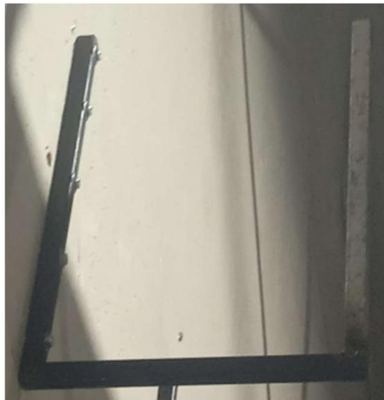
**Figura 2.10** Soporte tipo U modificado y anclado
