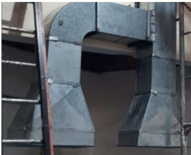
**Figura 2.24** Unión de la sección 1 a los extremos finales
