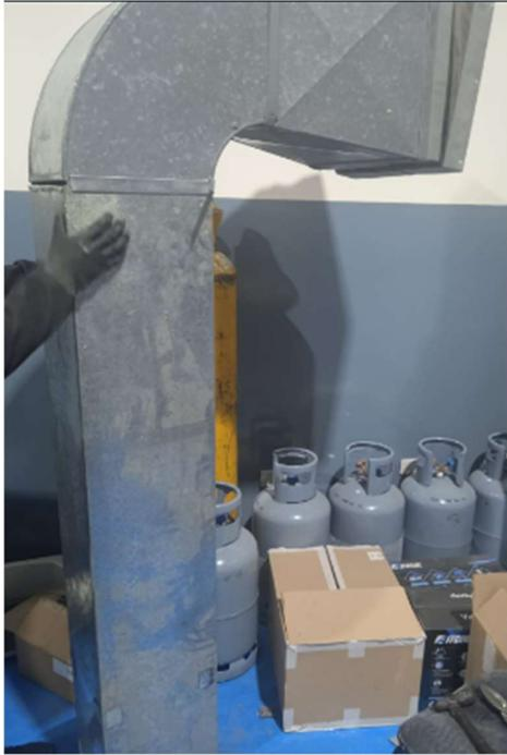
**Figura 2.14** Unión de las partes de la sección 2
