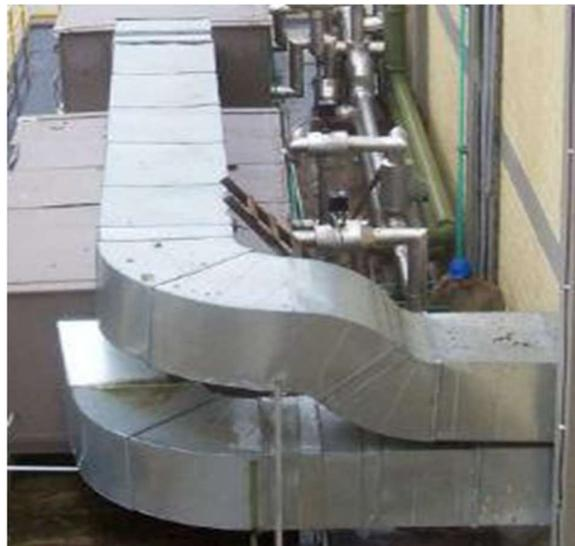
**Figura 1.1** Sección de ductos con codos, [6].
