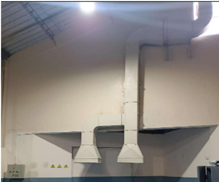
**Figura 3.2:** Sistema de extracción implementado tanto el sistema mecánico como el eléctrico
