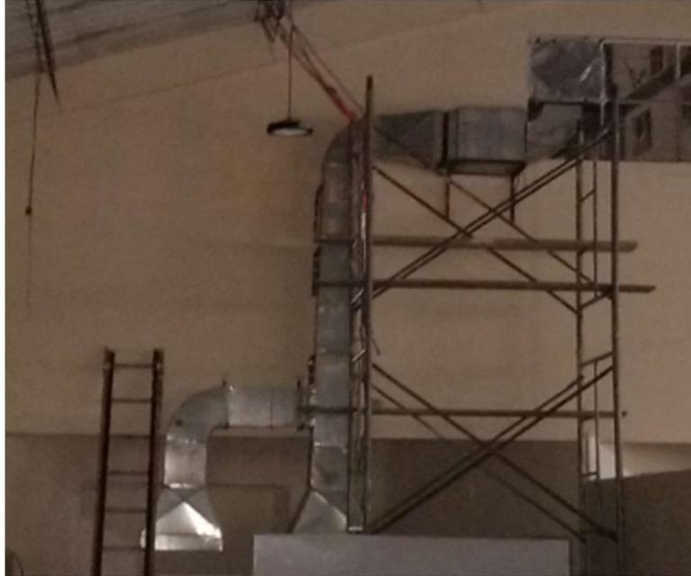
**Figura 3.1:** Sistema de extracción solo con la parte mecánica implementada
