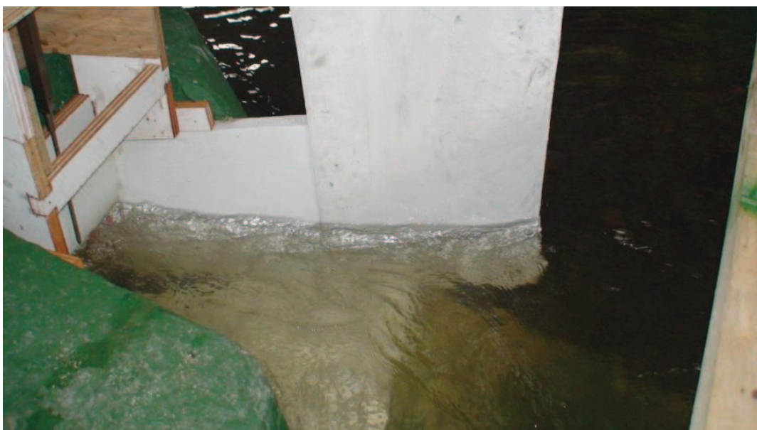
Fotografía No. 44: Mejora en la calidad del flujo en el extremo derecho por la eliminación de la curvatura en la pared. Modificación MB-3
