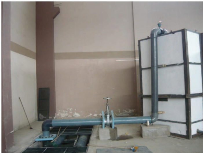
Fotografía No. 15: Instalación de la válvula de aire en la tubería
