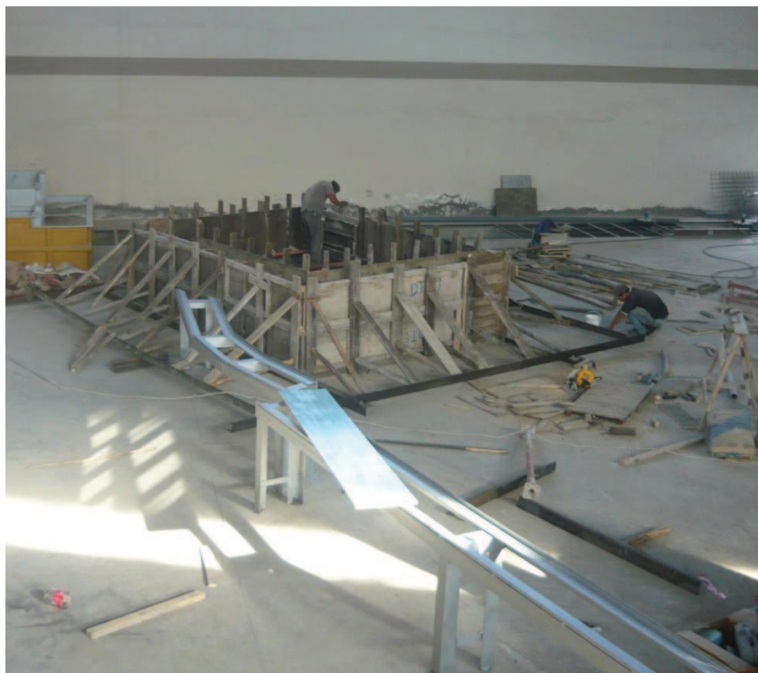
Fotografía No. 4: Ubicación de tubería en acrílico.
