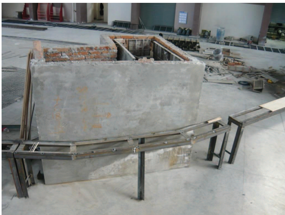
Fotografía No. 2: Vista Superior del Tanque de Descarga Intermedia.
