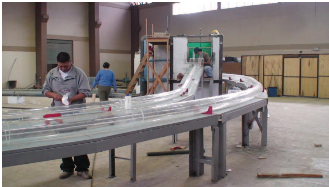
Fotografía No. 50: Instalación y armado de los túneles de Desvío y Descarga Intermedia.
