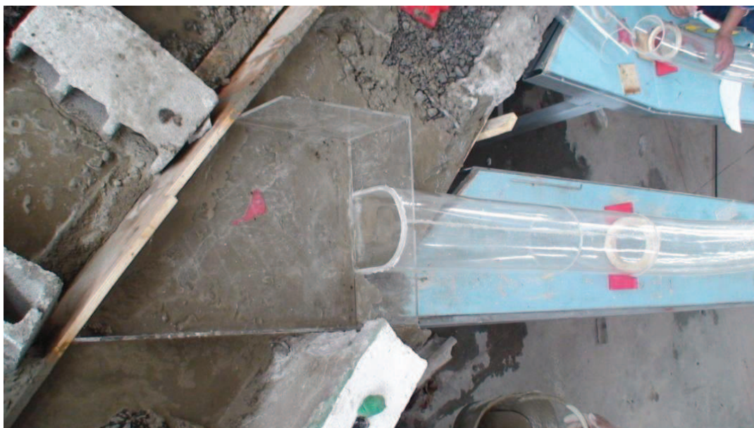
Fotografía No. 51: Instalación de la estructura de salida en el Túnel de Desvío.
