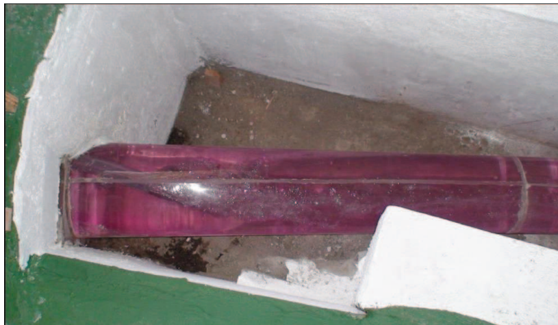
Fotografía No. 50: Ingreso de aire al Túnel de Desvío por medio de ventilación artificial.
