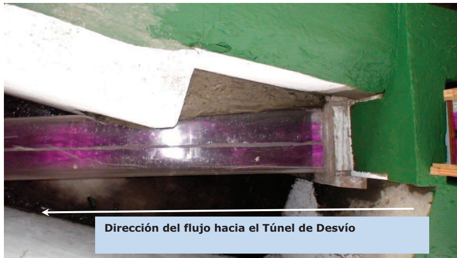
Fotografía No.69: Vista superior de la transición inicial entre las secciones cuadrada y circular, aguas abajo de la estructura de entrada.
