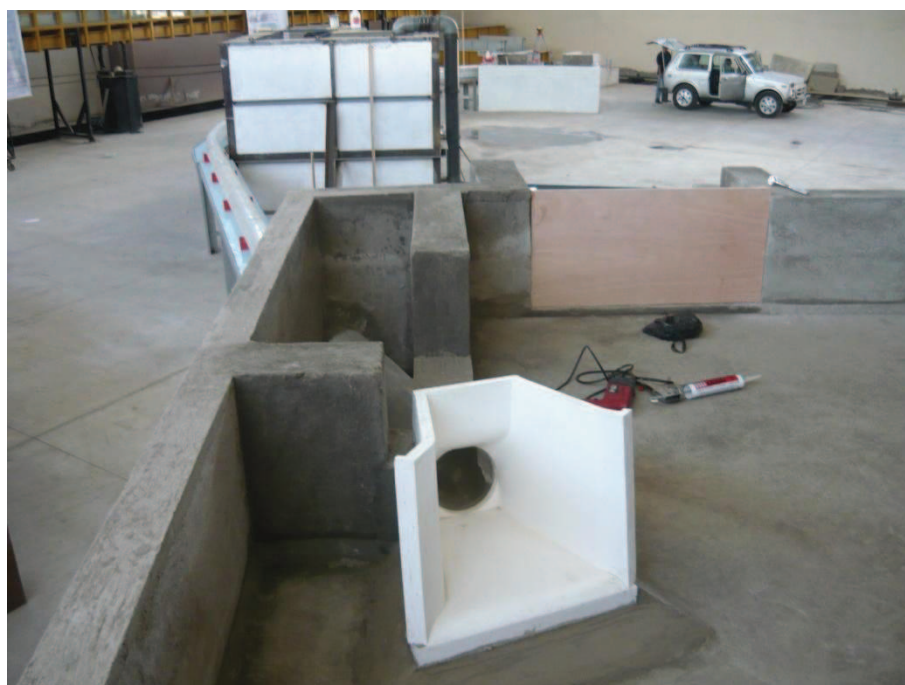
Fotografía No. 6: Colocación de estructura de entrada.
