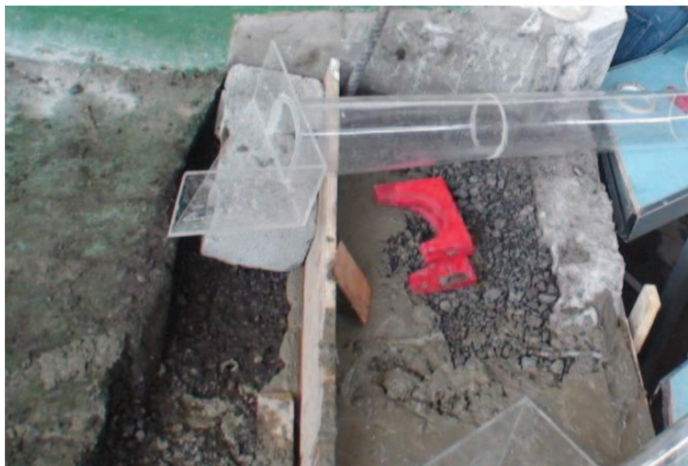
Fotografía No. 52: Instalación de la estructura de salida en la Descarga Intermedia.
