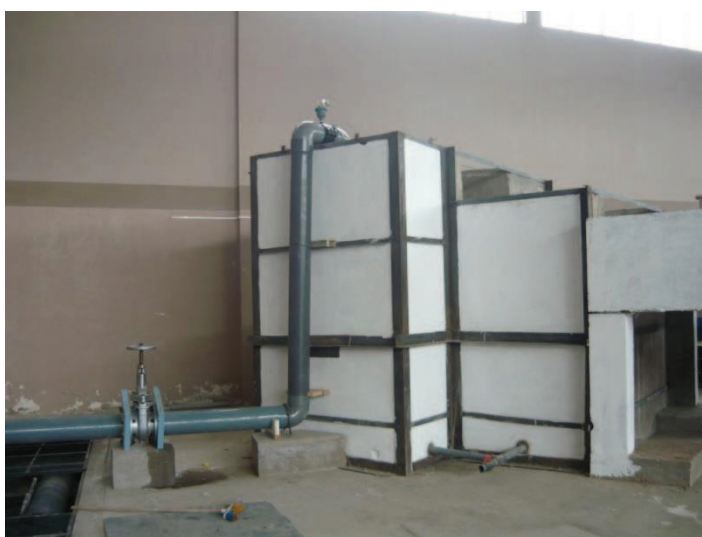
Fotografía No. 2: Vista superior de los tanques de entrada al Túnel de Desvío.
