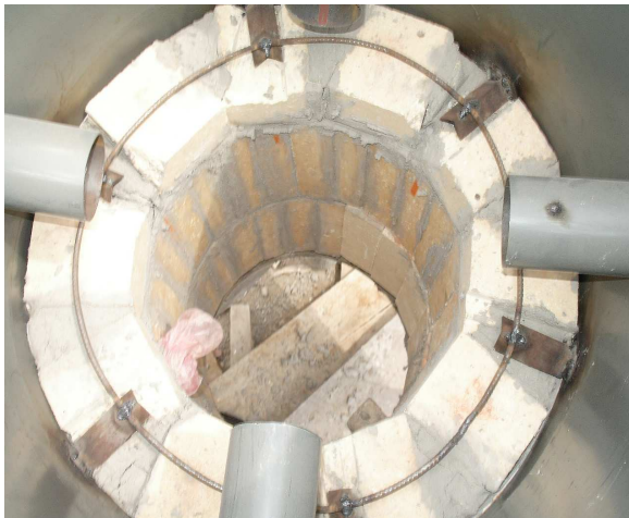
Fotografía 8. (Alineación de la etapa 1 a la base para la ubicación de los sujetadores)
