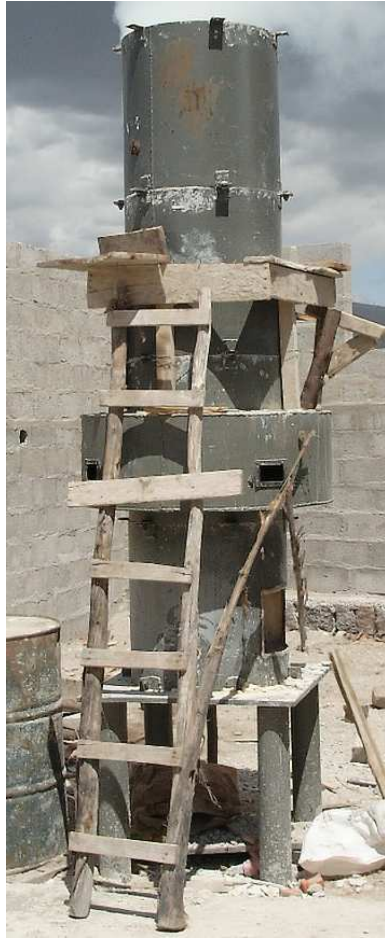
Fotografías 11-12. (Termino de la colocación del ladrillo y secamiento del horno)
