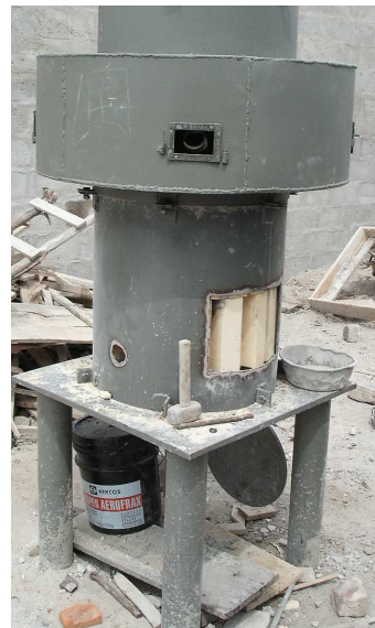
Fotografías 9-10. (Colocación del refractario en la etapa 1 y 2)
