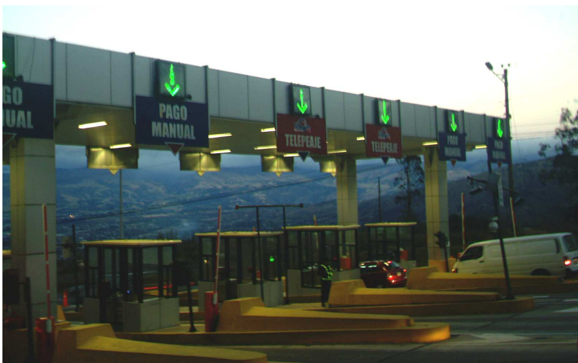
Figura 3.3 Peaje Túnel Guayasamín
