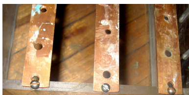
Sistema de Sujeción de las Barras de cobre electrolítico a la cuba
