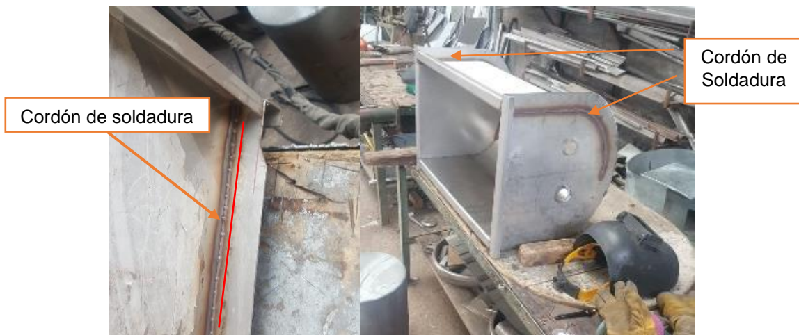
Figura 2.10. Unión permanente por medio de soldadura entre los elementos de la tina. Fuente: Propia.
