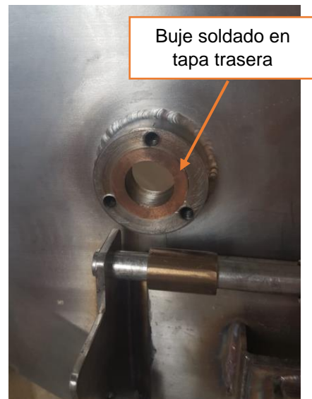
Figura 2.9. Colocación de buje para eje agitador. Fuente: Propia.
