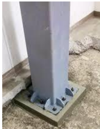
Figura 1.6. Viga empotrada
