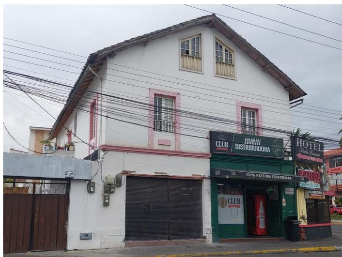
**Figura 2.7** Estructura de Mampostería de Ladrillo No Reforzado con Piso de Hormigón Armado
