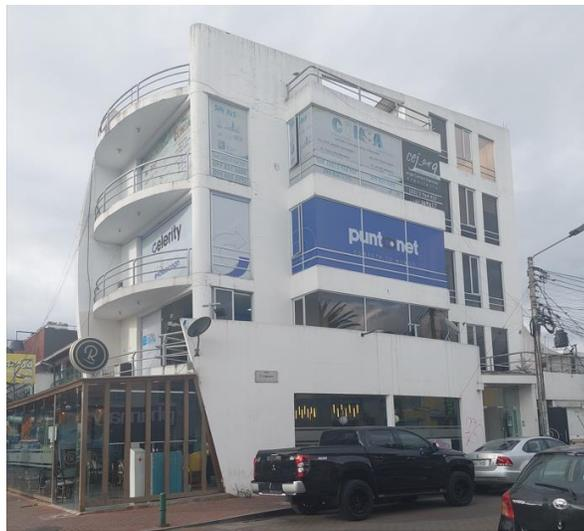
**Figura 2.10** Estructura de Hormigón Armado de 3 a 5 Pisos Sin Diseño Sismorresistente
