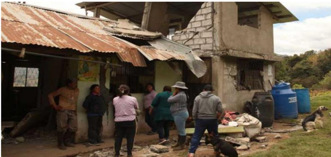
**Figura 2.8** Estructura de Hormigón Armado Sin Diseño Sismorresistente
