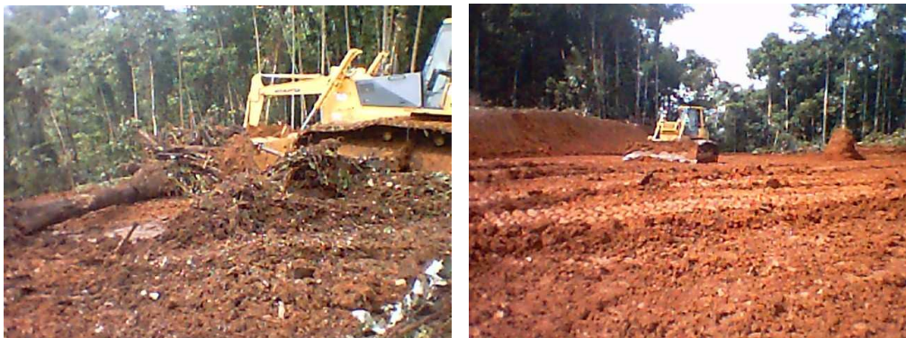
Figura 4.8: Elaboración de Plataformas GTA
