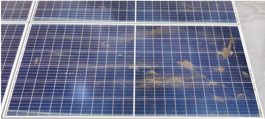
Figura 3.6. Panel con 20 g/m 2 de polvo [Elaboración Propia].
