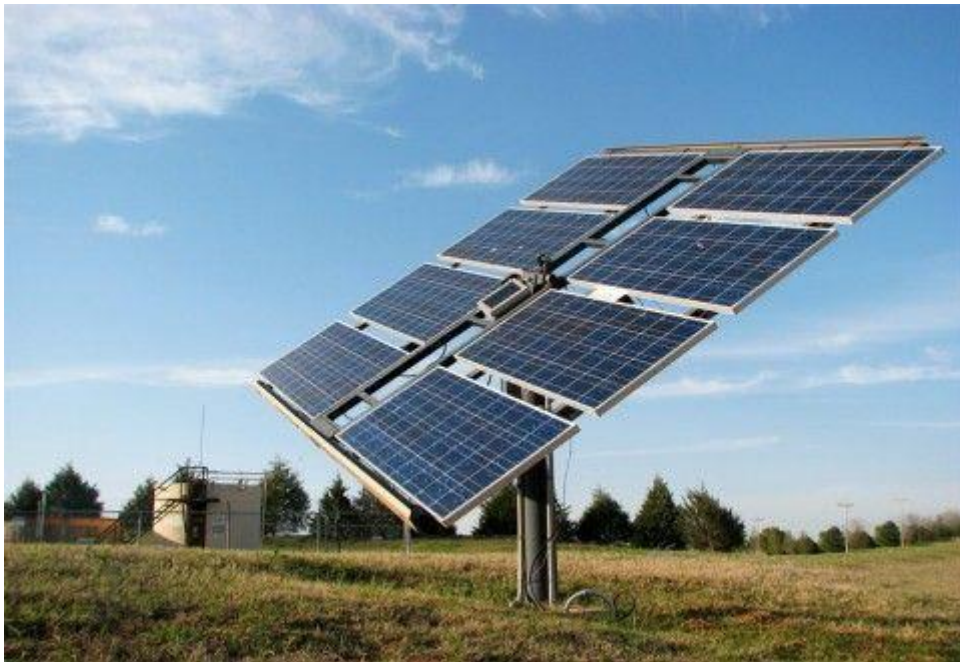
Figura 2.15. Estructura de montaje móvil [37].
