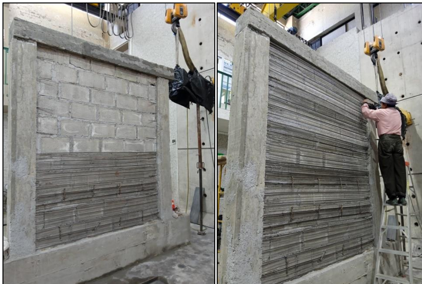
Figura 38: Colocación de la Malla Nervometal
