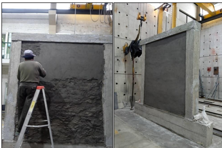
Figura 39: Enlucido del muro
