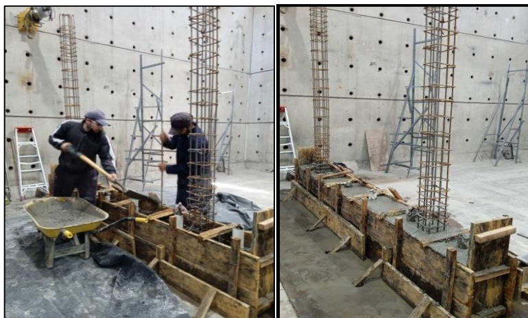
Figura 31: Colocación del hormigón en viga base
