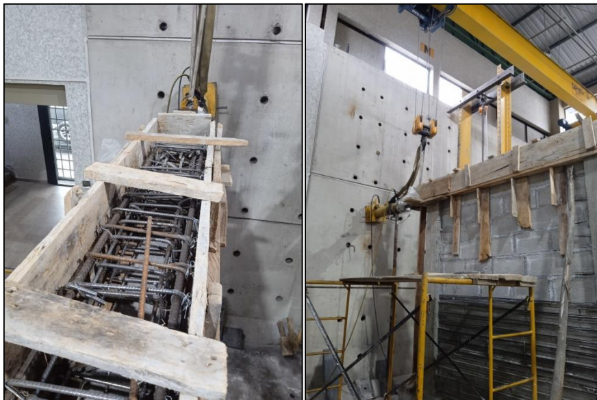
Figura 37: Elaboración de la viga superior
