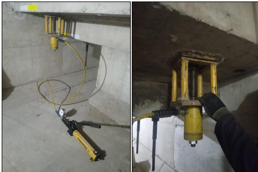
Figura 74: Pretensión de ejes
