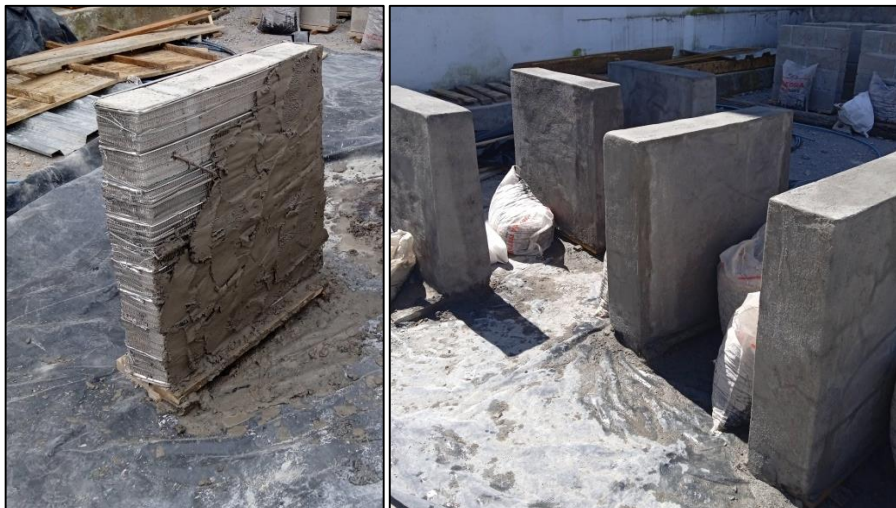
Figura 28: Enlucido de muretes
