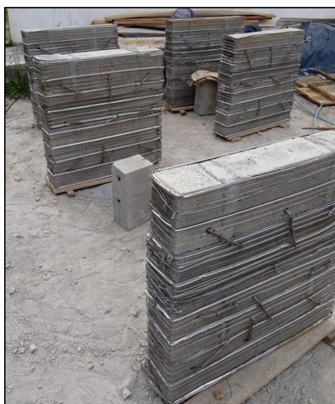
Figura 27: Muretes reforzados antes de ser enlucidos
