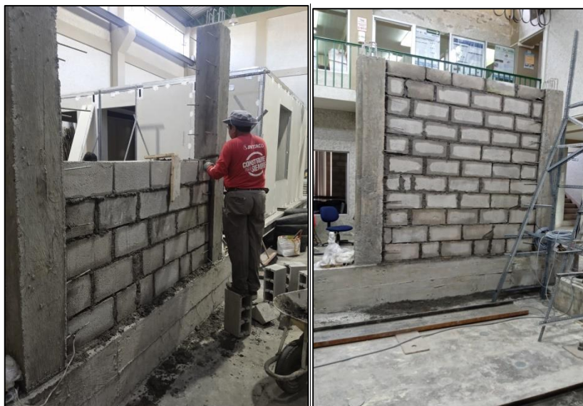
Figura 36: Elaboración del muro de mampostería
