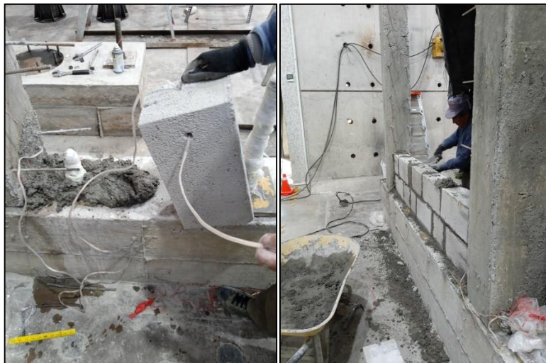
Figura 35: Primeras hiladas de bloques de hormigón
