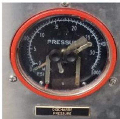
Figura 15. Manómetro de descarga Murphy (Escuela de operaciones SERTECPET, 2011).
