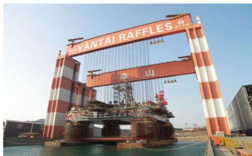
Figura 1.3. Puente grúa con pórtico fijo [8].
