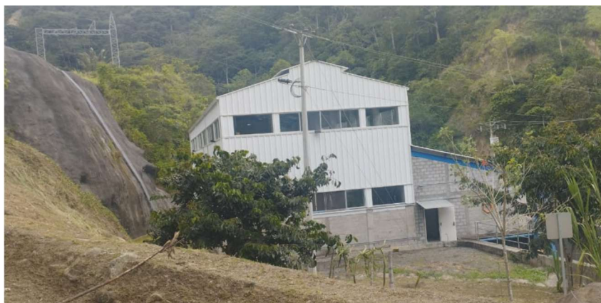
Figura 10. Casa de Máquinas Central Palmira Nanegal
