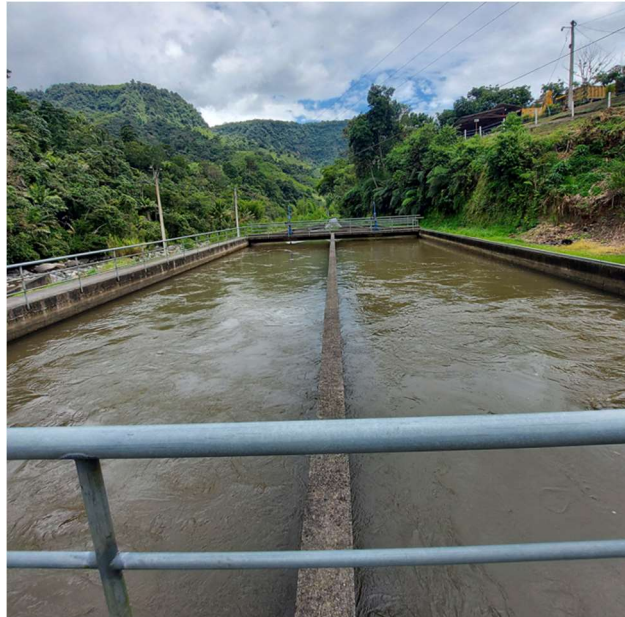
Figura 5. Desarenador Central Palmira Nanegal
