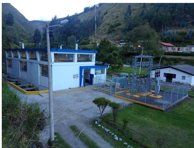
Figura 1.4. Central Hidroeléctrica Illuchi N2. (Fuente: Propia)
