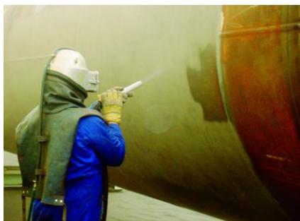
Figura 11. Aplicación de Sand Blasting (Fuente: Propia)
