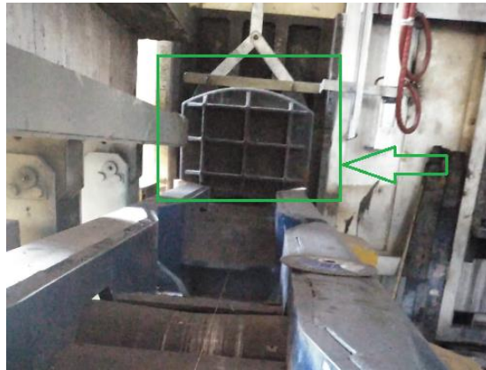
Figura 44. Puerta salida de palanquilla desde el horno hacia el camino de rodillos.
