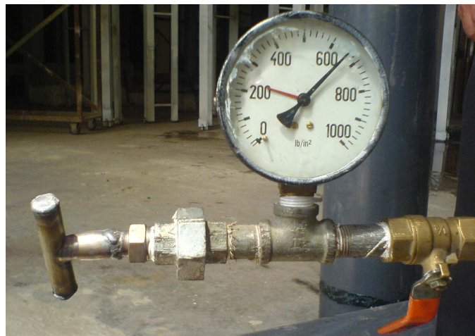
Figura 4.3 Válvula de ajuste y acople universal.
