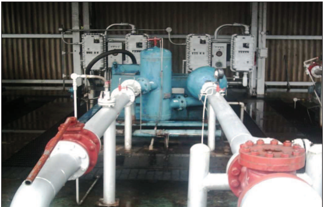
Foto No 2.20. Bomba Triplex de Transferencia (Marca NATIONAL)
