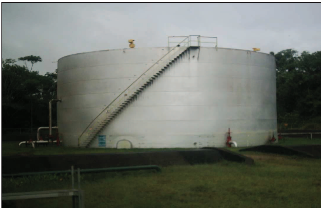
Foto No 2.16. Tanque de Surgencia o Reposo (32230 Barriles)
