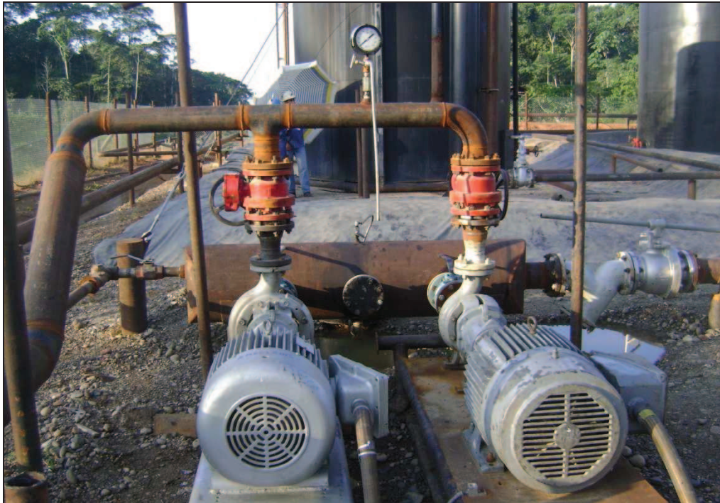
Foto No 2.33. Bomba de transferencia horizontal
