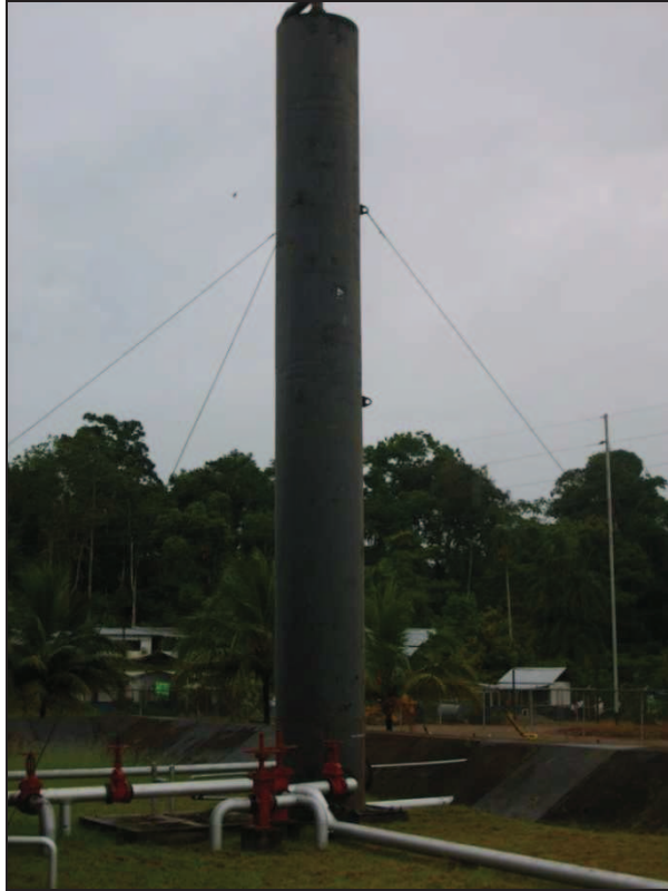
Foto No 2.12. Entrada, Descarga y By-pass de Bota de Gas
