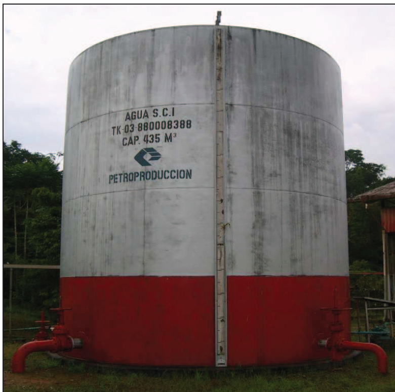
Foto No 2.25. Tanque de Almacenamiento de Agua (3000 Barriles)
