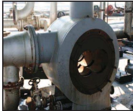
Figura No 3.34. Camisa reemplazable
