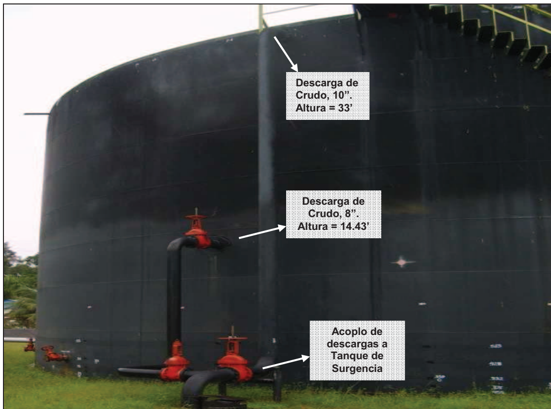
Foto No 2.16. Tanque de Surgencia o Reposo (32230 Barriles)
