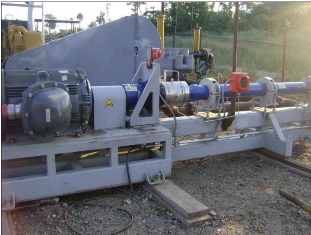
Foto No 2.33. Bomba de transferencia horizontal
