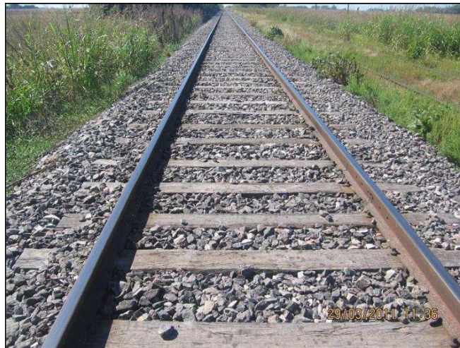
Figura 1.11. Vía férrea con balasto limpio. Fuente: (Nuevo Central Argentino S.A., 2014)
