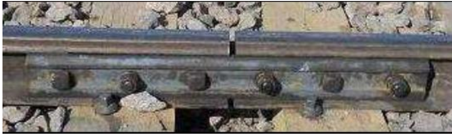
Figura 1.15. Juntas de riel. Fuente: (Nuevo Central Argentino S.A., 2014)
