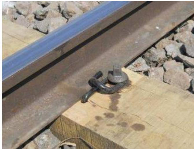
Figura 1.14. Fijación en estructura de vía férrea. Fuente: (Nuevo Central Argentino S.A., 2014)
