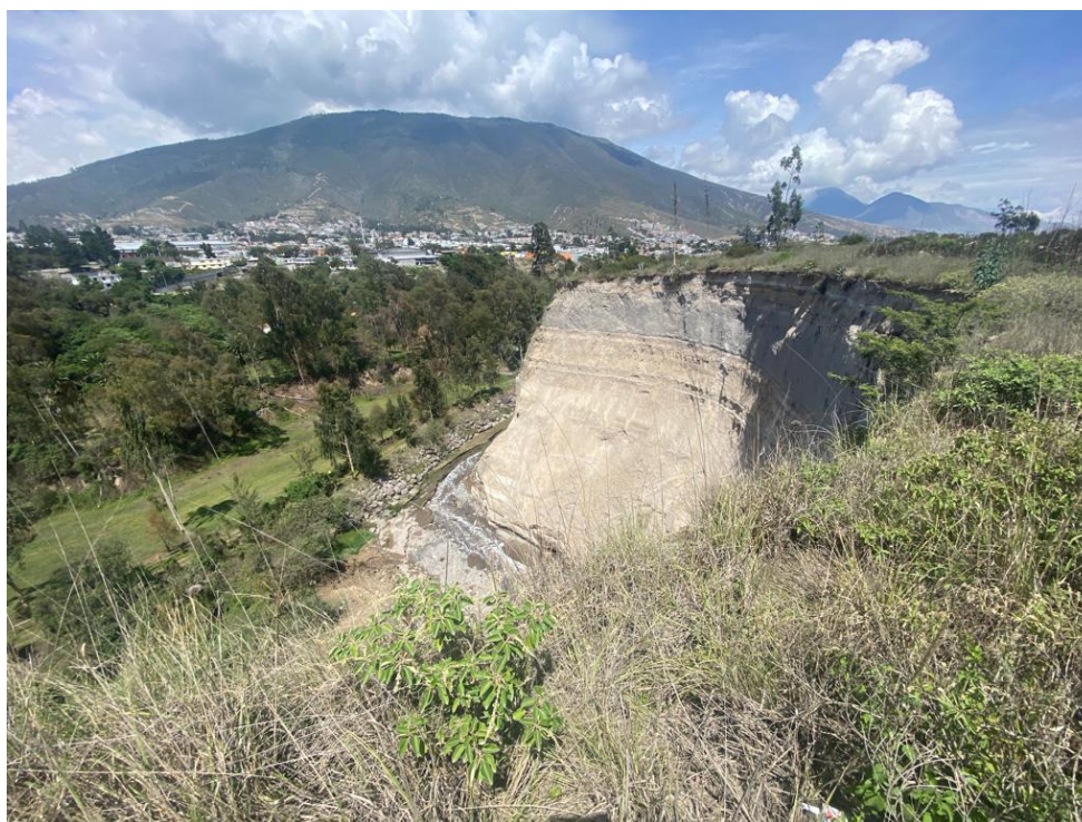
Figura 10: Río Monjas, zona de deslizamiento activo Ciudad Bicentenario - Av. Simón Bolívar, Punto 3.
