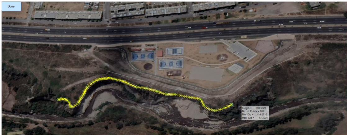
Figura 42: Medidas del deslizamiento 2022.
