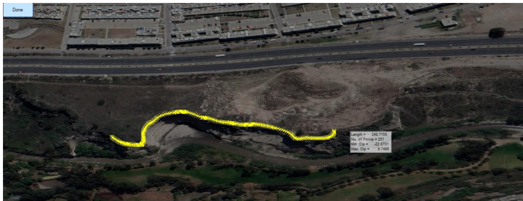
Figura 41: Medida del deslizamiento 2021.
