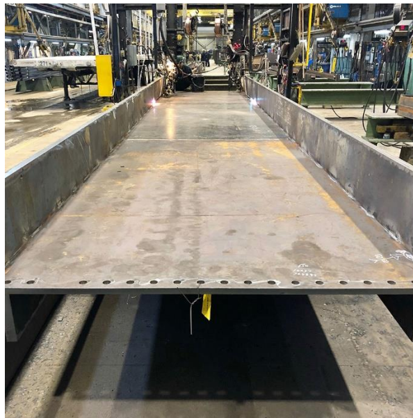
Figura 1.3. Soldadura de las placas del alma y patines de una viga con sección I Fuente: Canam Structures, 2022 [10]
