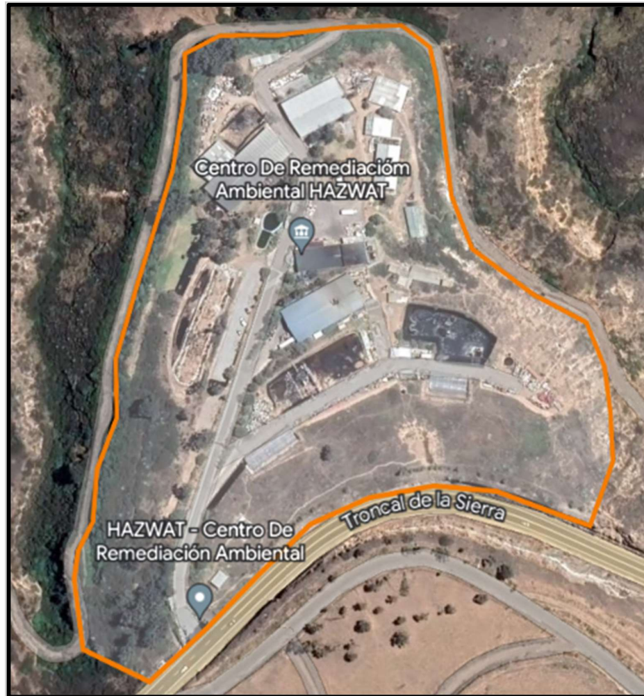
Figura 2. Ubicación centro de Remediación Ambiental
