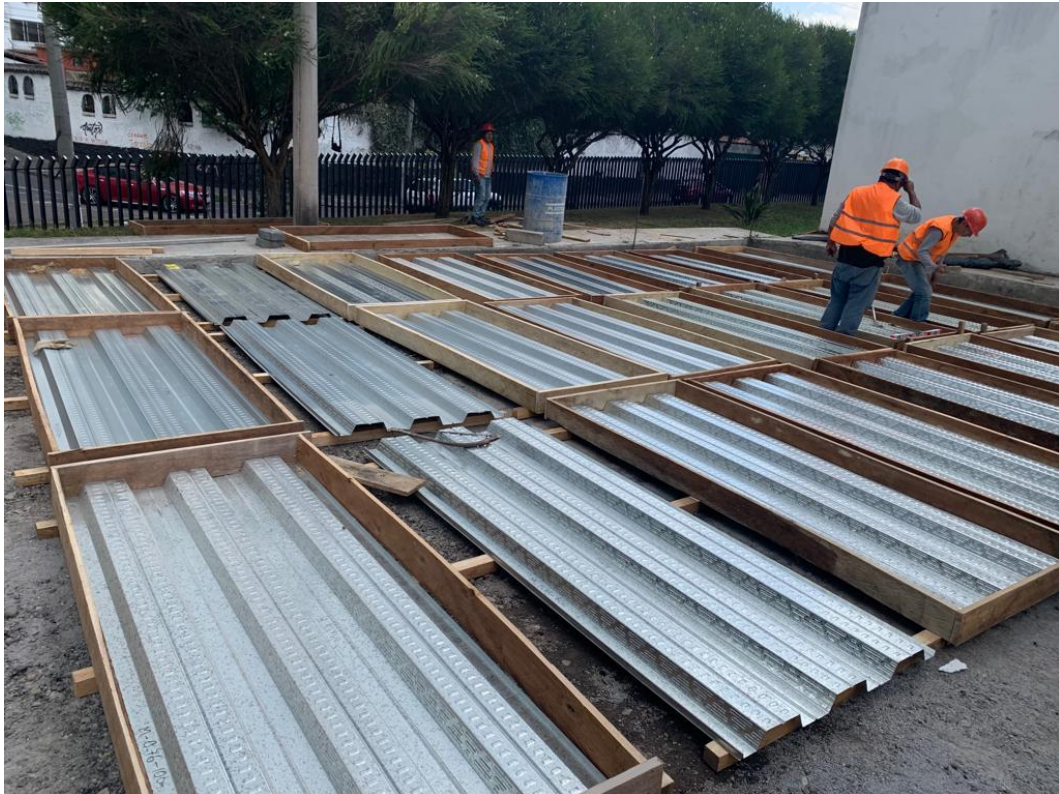
Figura 2.2. Láminas de acero encofradas.
