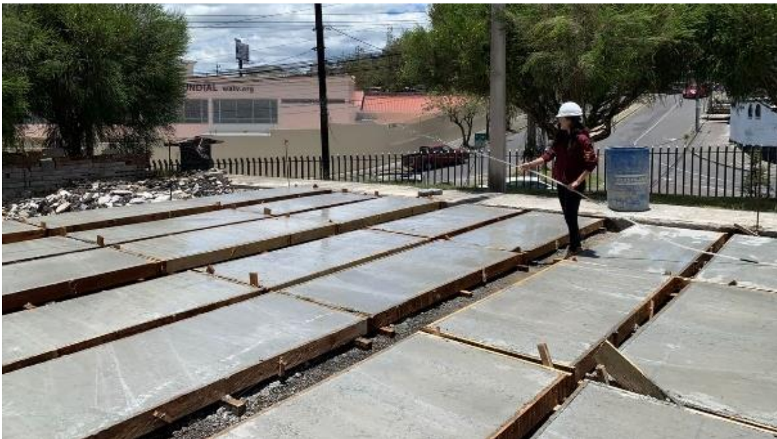
Figura 2.5. Curado del hormigón
