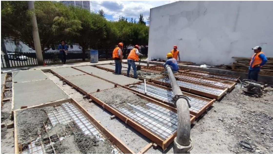
Figura 2.4. Vertido del hormigón estructural.
