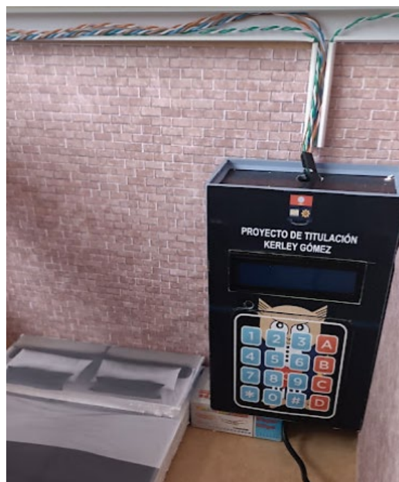
Figura 3.68 Ubicación de la caja de alarma
