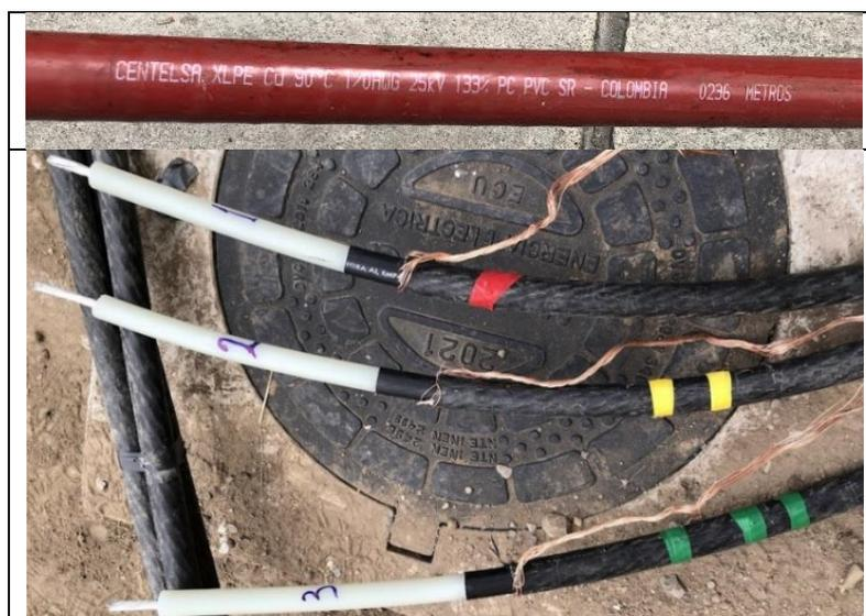
**Figura 10.** Cables de potencia de 25 kV con indicadores de fase.
