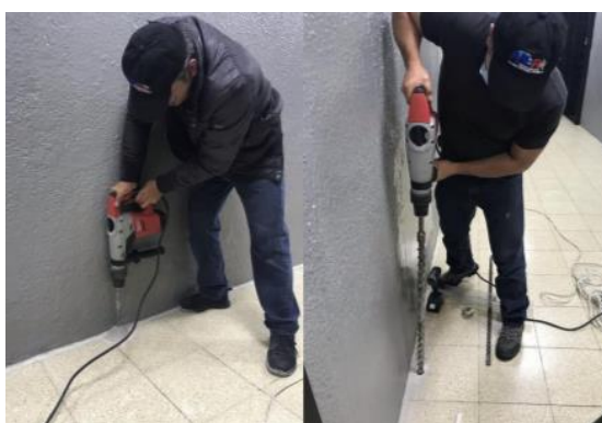
Figura 2.1. Perforación de losa para conductor de tubo de 1" y 1 ½" - EPN [1].
