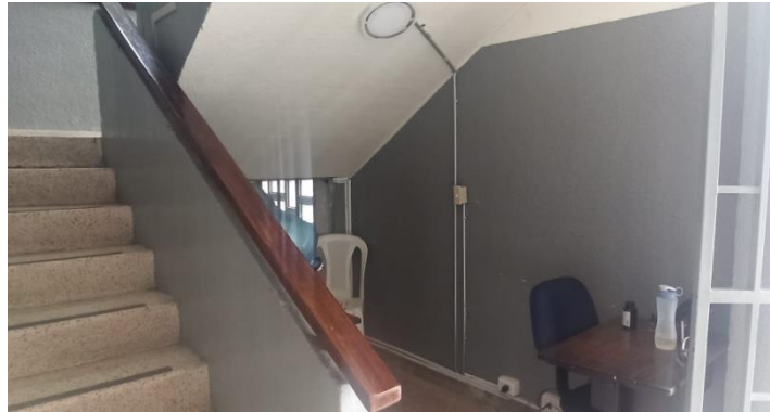
Figura 2.13. Actual punto de vigilancia el edificio #14.
