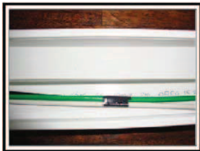
Figura 3-2. Instalación de cables para el Sistema Eléctrico.
