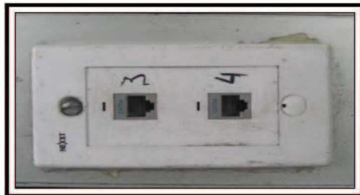
Figura 2-3. Face plate sin un correcto etiquetado.
