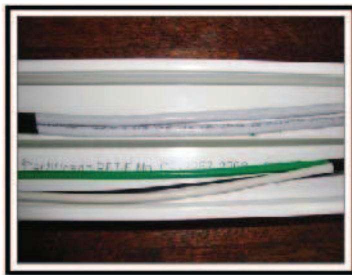
Figura 3-3. Instalación del cable UTP cat 5e.
