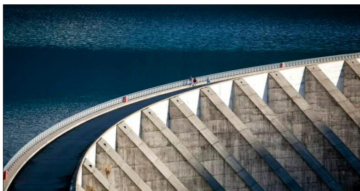
Figura 3. Presa de contrafuerte Roselend, Saboya. Fuente: (Feraud, 2019)
