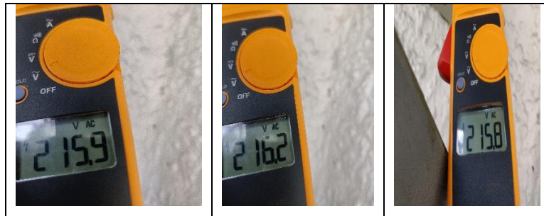
Figura 2.15 Medición de voltaje de línea.
