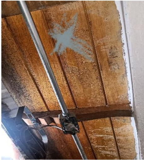
Figura 2.7 Identificación de puntos de iluminación.
