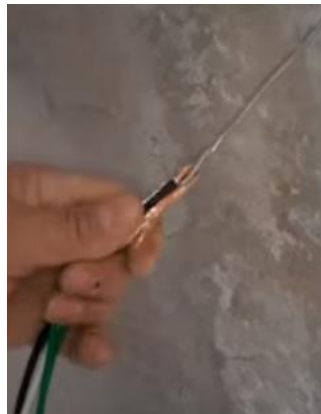
Figura 2.10 Envío de alambre guía por tubería.
