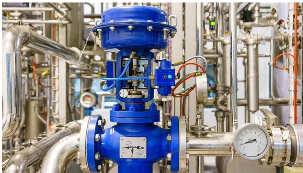
Figura 1.3, Actuador y válvula de control. (chemical processing, 2020)
