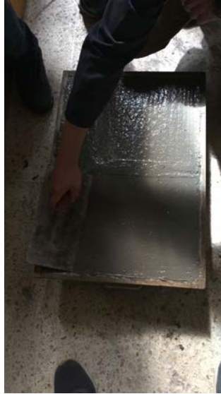
Figura 25 Proceso de alisado de la placa de hormigón reforzado con fibra
