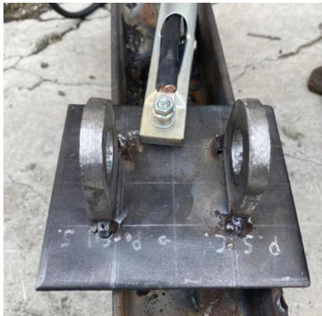
Figura 2.17 Proceso de soldadura de los sujetadores
