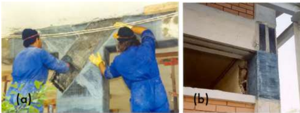
Figura 7 Reforzamiento externo de elementos de concreto.
