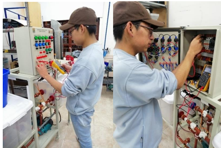
Figura 3.1. Prueba de conductividad del gabinete eléctrico.
