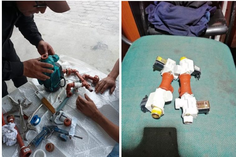
Figura 2.27. Proceso de conexión de tuberías y dirección de electroválvulas.
