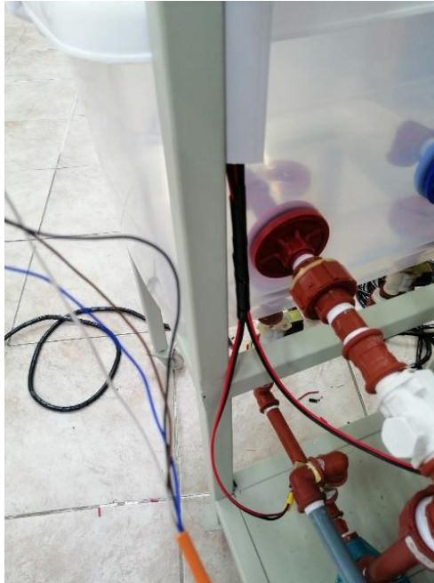
Figura 2.29. Instalación de canaletas y serpentinas.
