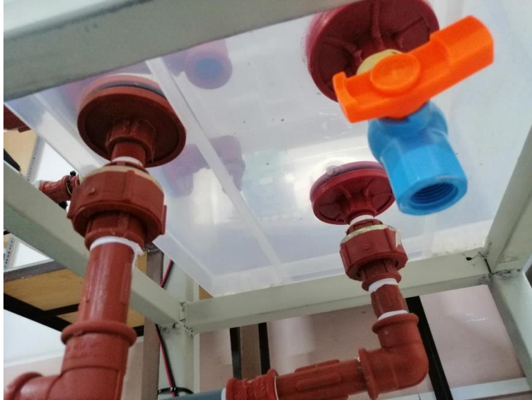
Figura 3.8. Pruebas de fuga de agua en tanques.
