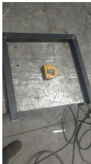
Figura 2.22. Soldado de uniones de la estructura.
