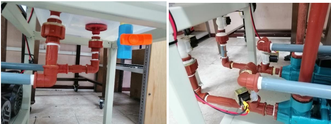
Figura 3.9. Pruebas de fuga de agua en secciones críticas.
