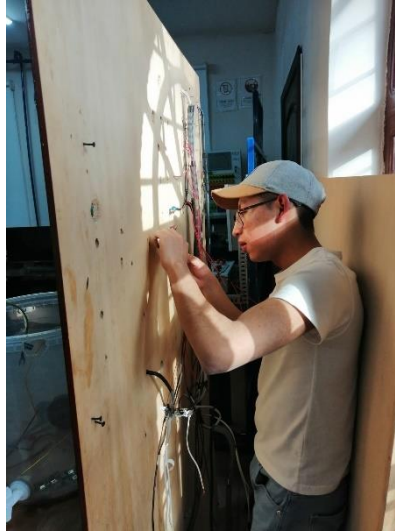
Figura 2.8. Desmontaje de borneras.
