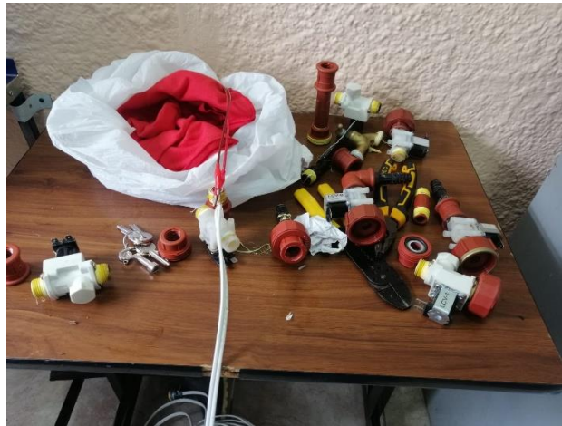
Figura 2.4. Estado actual de las electroválvulas.
