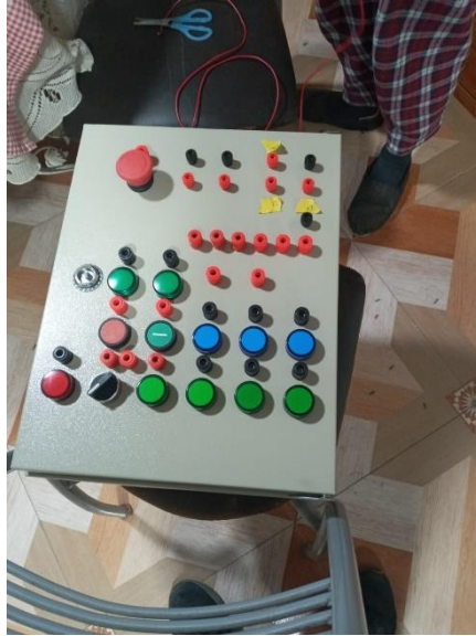
Figura 2.32. Colocación de luces piloto y elementos de maniobra.
