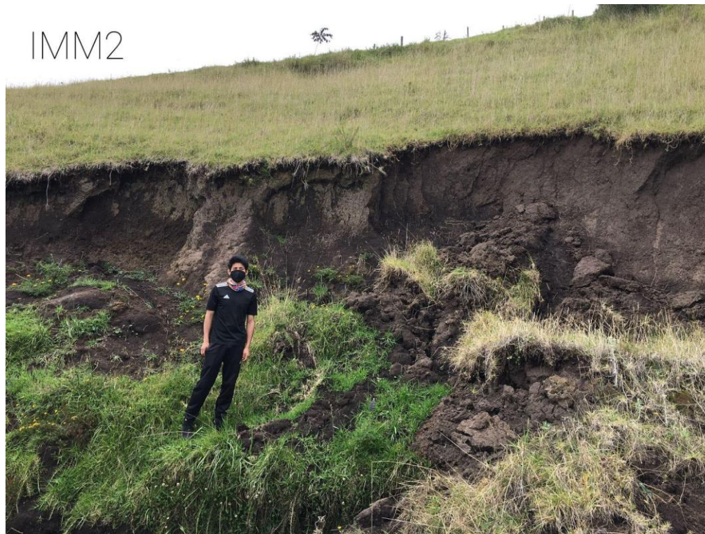
Fotografía IMM2. Deslizamiento rotacional en el corte vial del barrio de San Luis de Miravalle. Fuente: Marco Yanguicela
