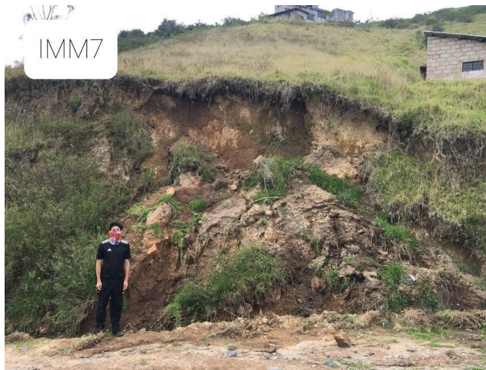
Fotografía IMM7 Caída en el corte vial del barrio de San Luis de Miravalle. Fuente: Marco Yanguicela
