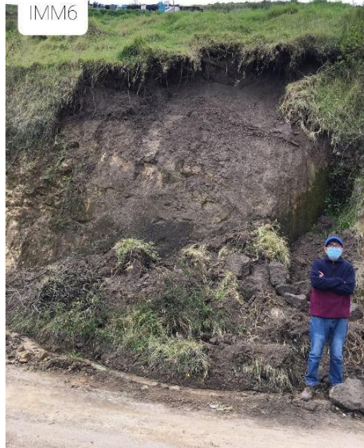
Fotografía IMM6 Caída en el corte vial del barrio de San Luis de Miravalle. Fuente: Marco Yanguicela
