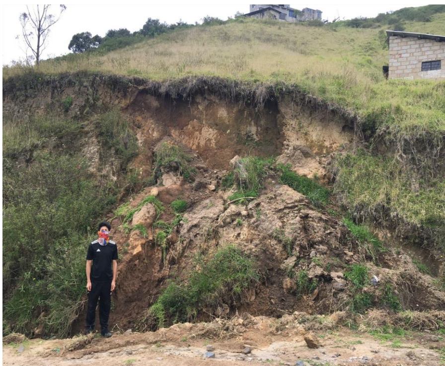
Figura 1.2. Derrumbe en el corte vial del barrio de San Luis de Miravalle. Fuente: Marco Yanguicela
