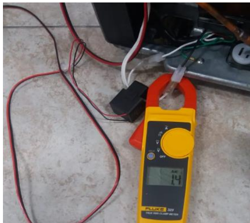
Figura 3.12 Instalación de transformadores de corriente para medición de corriente.
