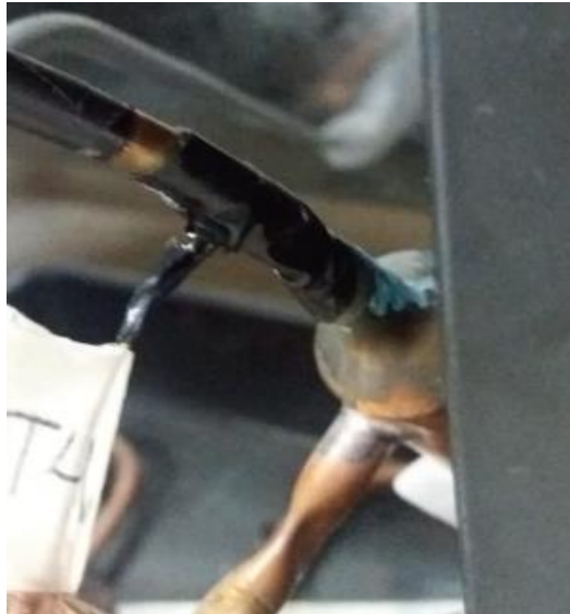
Figura 2.9 Ubicación de sensores en el filtro deshidratador.
