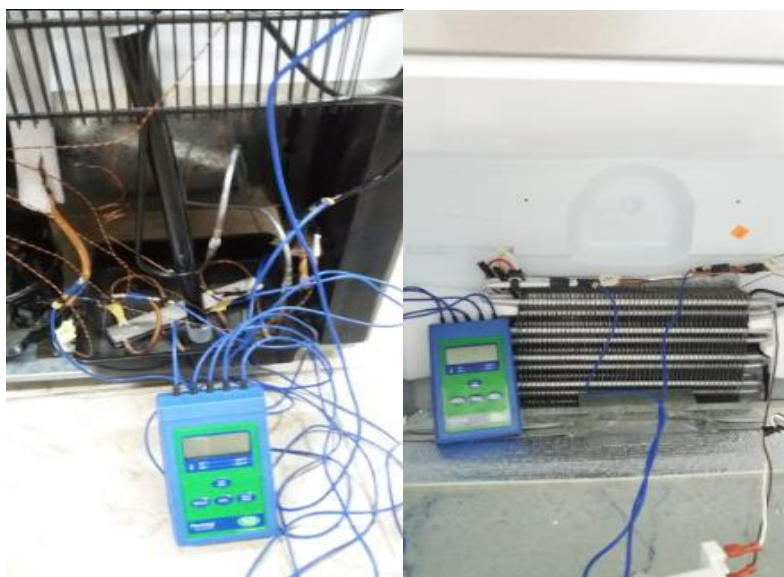
Figura 3.2 Instalación equipos Penta III.
