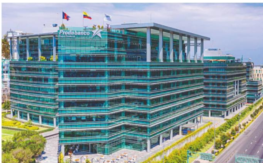
Figura 3.3 Edificio Produbanco – Ekopark Torre 2.
