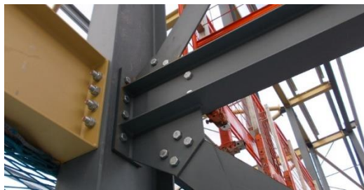
Figura 2.1 Ejemplo de conexión empernada
