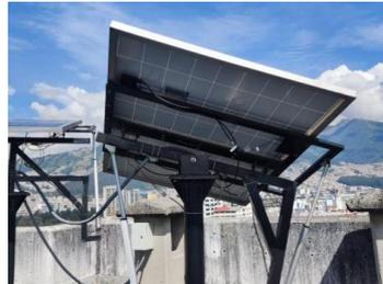
**Figura 1.8.** Panel fotovoltaico de dos ejes.
