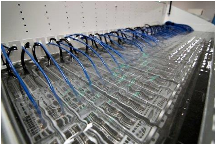
Figura 2.3.8. VDC con refrigeración por inmersión [33]
