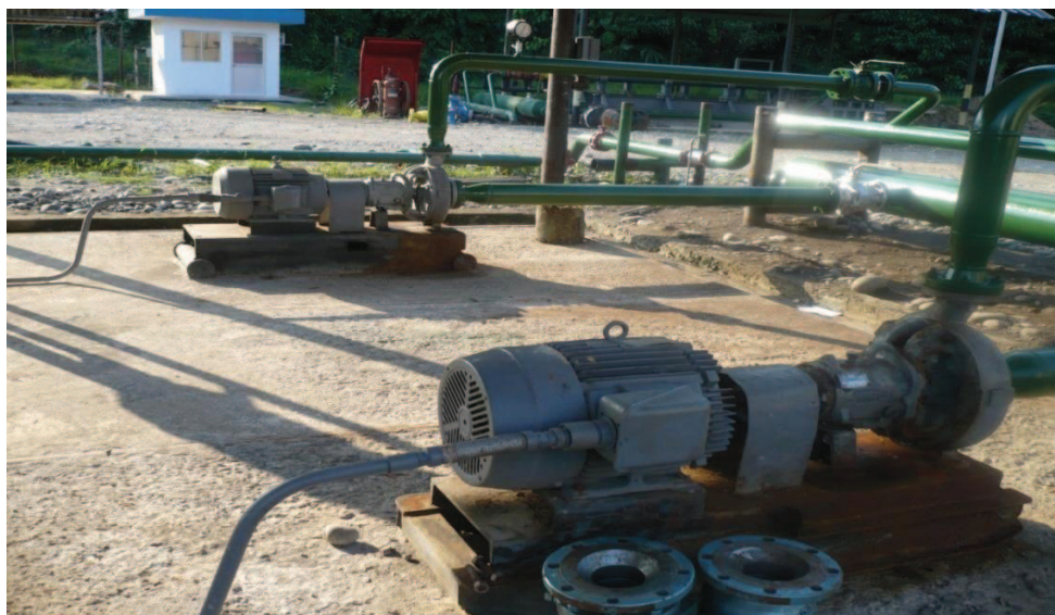
FOTO A.2.13. SISTEMA DE REINYECCIÓN DE AGUA, SISTEMA DE TRANSFERENCIA. ESTACIÓN YULEBRA.
