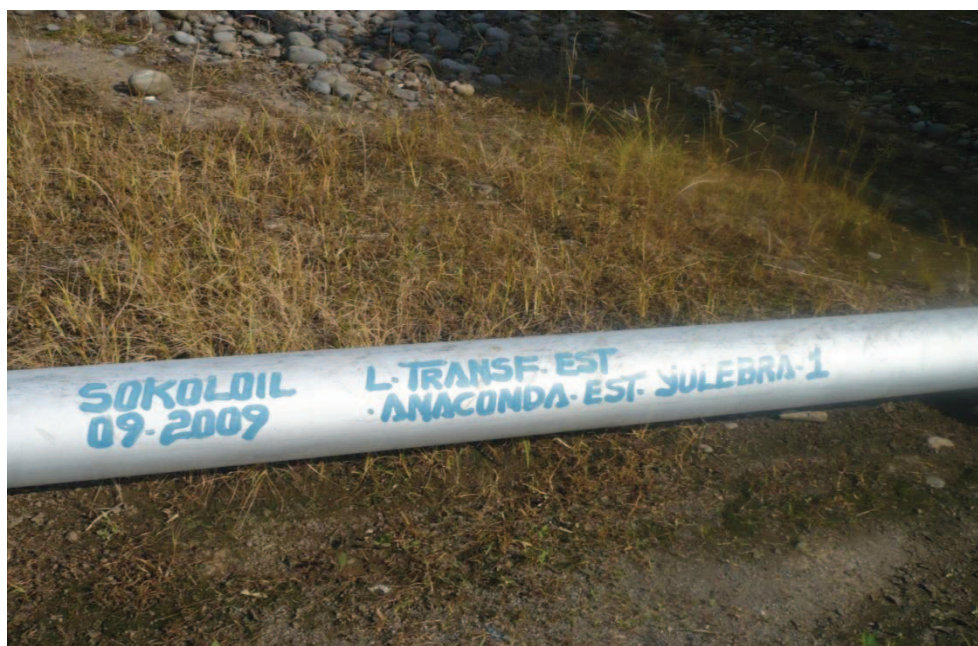
FOTO A.2.24. LÍNEA DE TRANSFERENCIA ANACONDA-YULEBRA 01. ESTACIÓN ANACONDA
