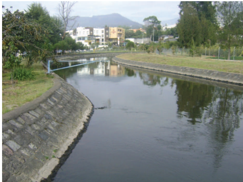
Figura 2.3. Canal de acceso al reservorio de la CH. Cumbayá.
