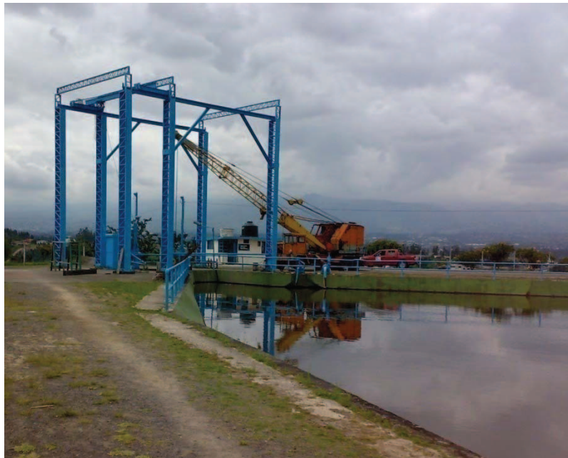
Figura 2.9. Tanque de presión reservorio CH Cumbayá.
