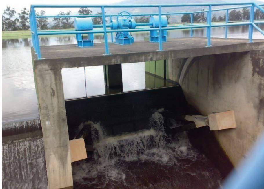
Figura 2.7. Acceso al túnel by – pass.
