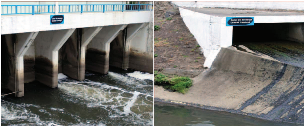
Figura 2.13. Canal de descarga.
