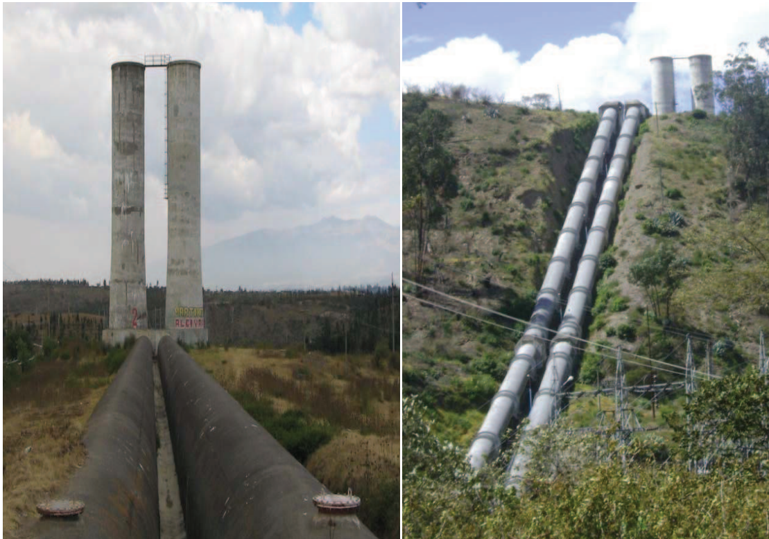
Figura 2.10. Tubería de presión y chimeneas de equilibrio.
