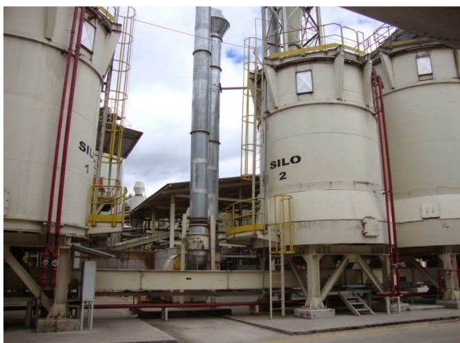
FIGURA 3.10 SILOS EN DONDE SE ALMACENA LA MATERIA PRIMA HÚMEDA
