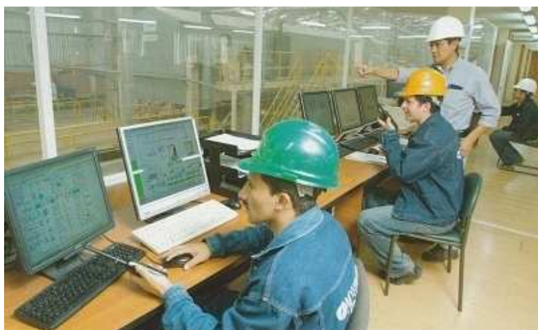
FOTOGRAFÍA 2: CUARTO DE CONTROL DEL SECADERO
