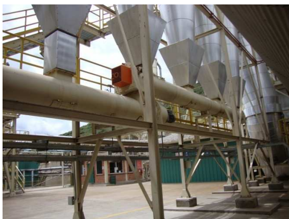
FIGURA 3.27 REINCORPORACIÓN DEL MATERIAL DESDE LOS CICLONES AL PROCESO
