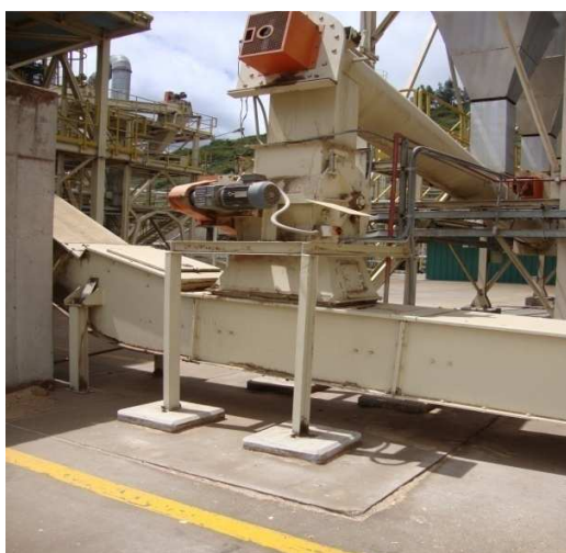
FIGURA 3.27 REINCORPORACIÓN DEL MATERIAL DESDE LOS CICLONES AL PROCESO
