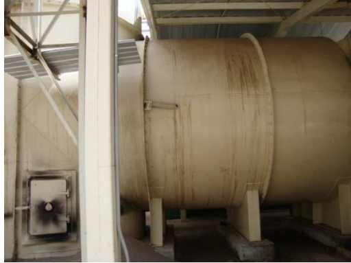
FIGURA 3.7 SILO 4 EN DONDE SE ALMACENA EL POLVO DE MADERA PARA SU POSTERIOR UTILIZACIÓN COMO COMBUSTIBLE
