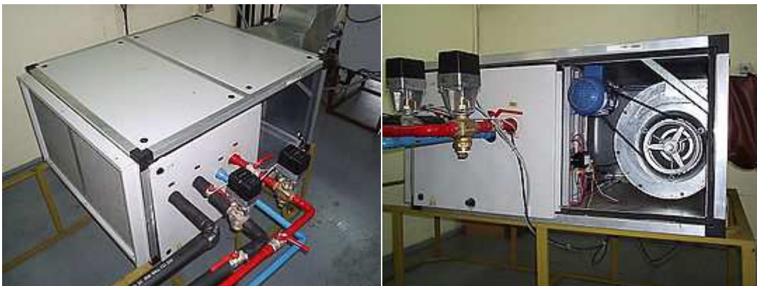
Figura 1.23 Unidad manejadora de aire
