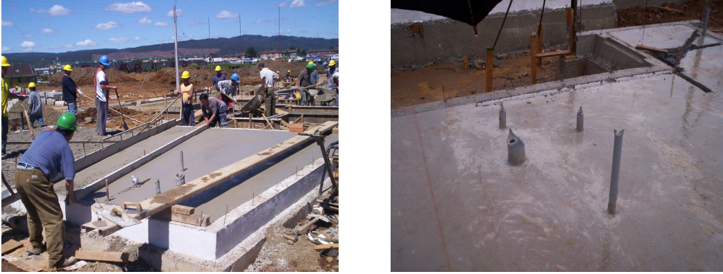
Fig. 5.21 Colocación del hormigón con aditivo impermeabilizante
