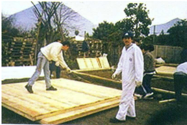
Fig. 5.43 Fabricación de entramado de entrepiso en obra
