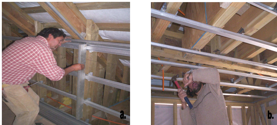
Fig. 6.11 a. Acoplamiento de la estructura de aluminio hacia el entramado vertical. b. Montaje de la estructura de aluminio hacia el entramado horizontal
