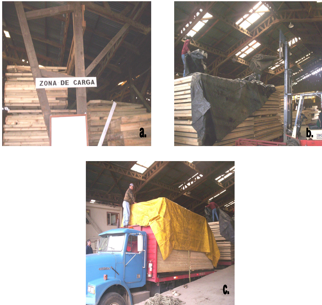
Fig. 5.33 a. Zona de carga en donde se deposita los prefabricados b. Colocación de los entramados en la plataforma del transporte c. Protección de los prefabricados con lonas impermeables
