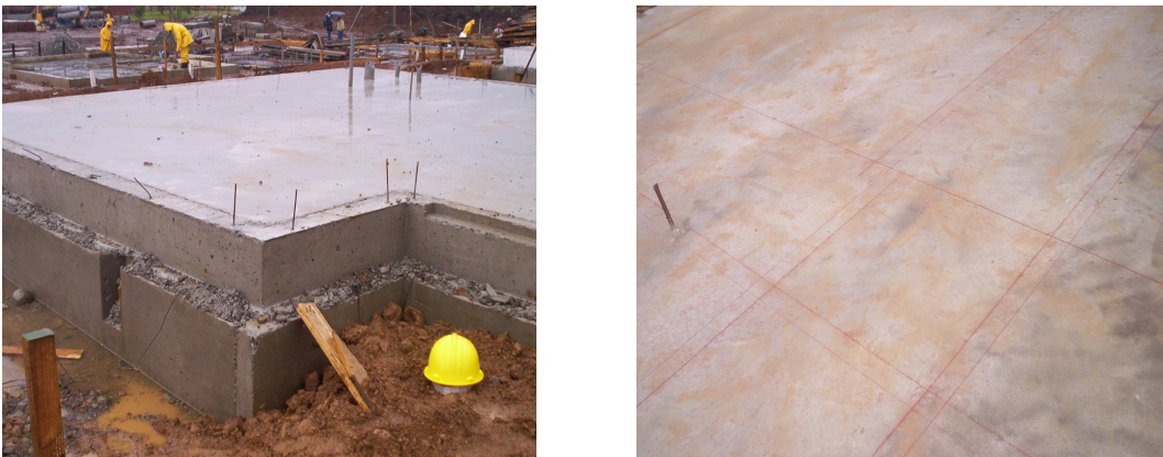
Fig. 5.22 Plataforma de hormigón con instalaciones y ejes de los entramados verticales
