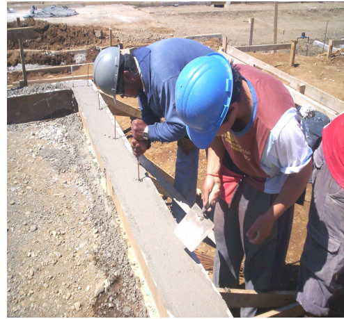
Fig. 5.13 Colocación de acero de 8 mm
