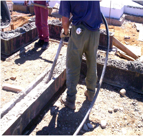
Fig. 5.12 Vibrado del hormigón
