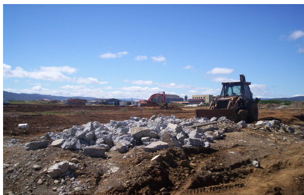
Fig. 5.2 Desbanque del terreno usando cargadora
