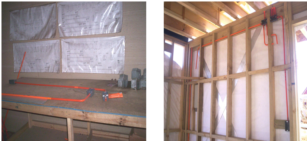
Fig. 5.31 Elaboración del entramado vertical con instalaciones eléctricas
