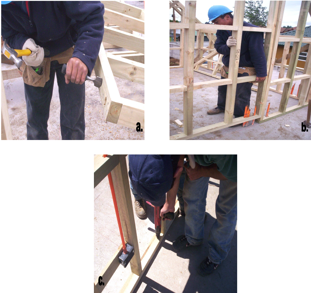
Fig. 5.38 a. Realizando un orificio en la solera inferior con un formón para permitir el paso de las tuberías b. Montaje del entramado vertical interior (panel) c. Anclaje de los paneles interiores a la plataforma de hormigón utilizando un fulminante
