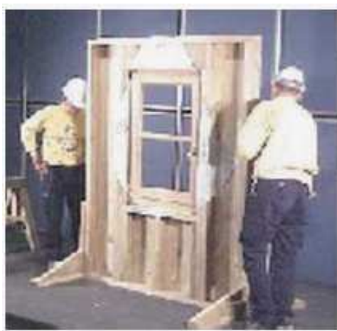
Fig. 6.8 Recubrimiento con lámina sintética en ventana
