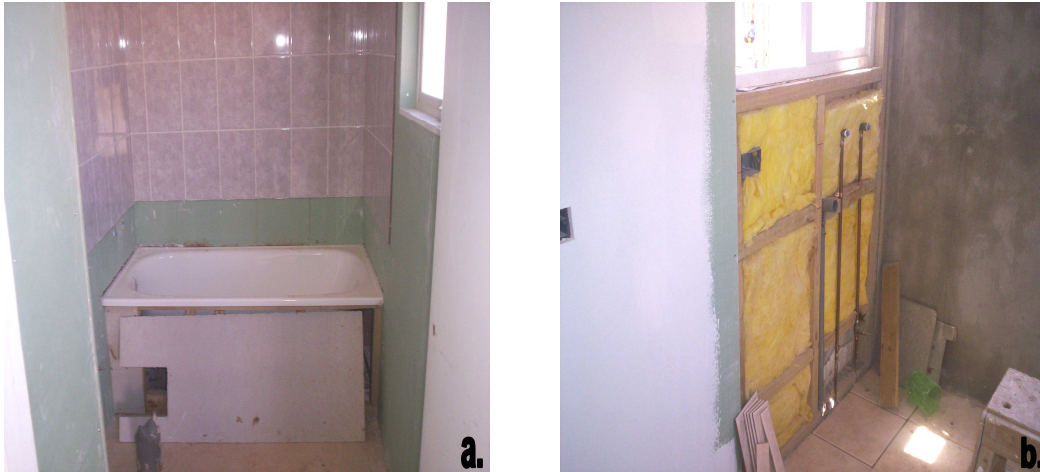
Fig. 6.13 Área a revestir antes de la instalación de azulejos (a) y empastados (b)
