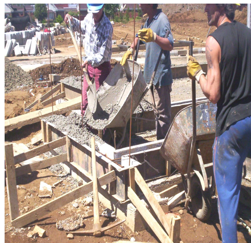
Fig. 5.11 Llenado del encofrado con hormigón
