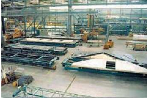
Fig. 5.47 Fabricación de estructura de techumbre en taller
