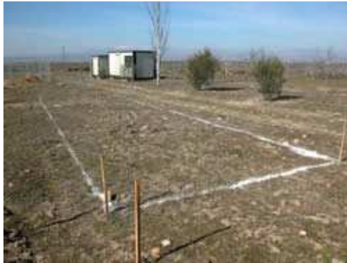
Fig. 5.1 Replanteo de terreno
