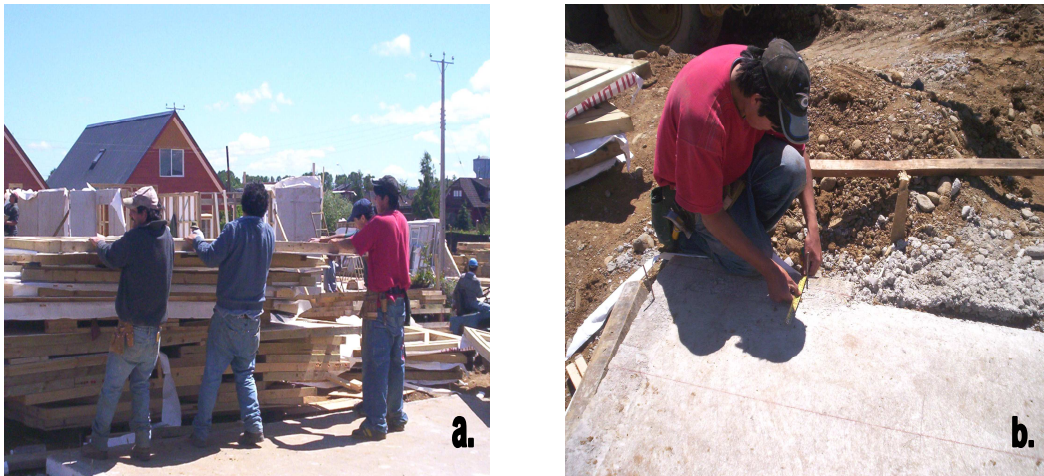
Fig. 5.34 a. Verificación de los ejes de acuerdo al plano de montaje b. Obtención del entramado vertical en el lugar de descarga en obra para su montaje
