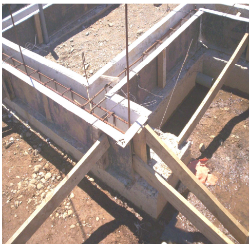
Fig. 5.10 Encofrado para cadena de amarre
