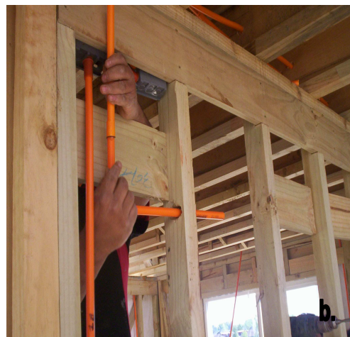
Fig. 6.3 a. Taladrando la solera superior para introducir la tubería de instalación eléctrica b. Tubería encajada en pie derecho
