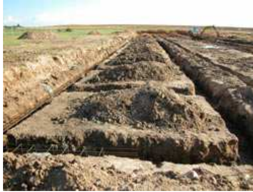
Fig. 5.3 Excavación para cimiento
