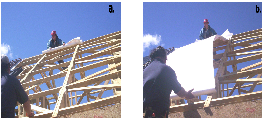
Fig. 6.6 a. Preparación de la lamina sintética previo a su instalación. b. Tendido de la barrera de humedad sobre la estructura de techumbre
