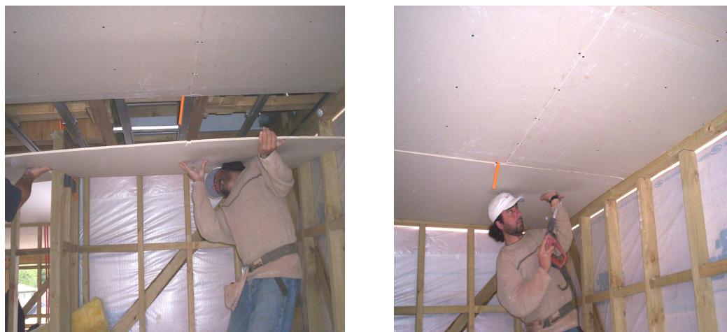
Fig. 6.12 Colocación de planchas de fibrocemento sujetadas a la estructura de aluminio
