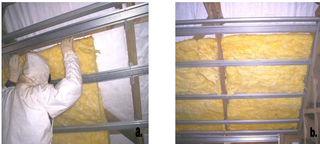
Fig. 6.10 a. Instalación de la lana de vidrio. b. Aislamiento acústico y térmico instalado
