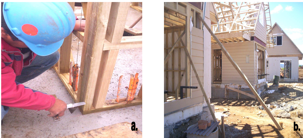
Fig. 5.36 a. Verificación de la verticalidad de los paneles b. Utilización de vigas de madera ancladas al suelo para mantener el aplomo de los paneles
