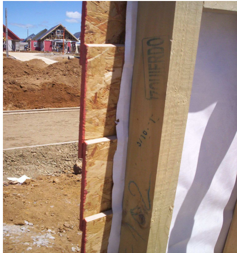
Fig. 6.5 Recubrimiento con lámina sintética
