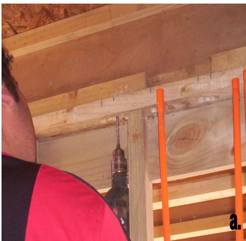
Fig. 6.3 a. Taladrando la solera superior para introducir la tubería de instalación eléctrica b. Tubería encajada en pie derecho
