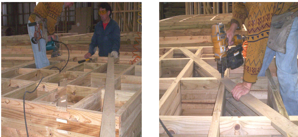
Fig. 5.30 Colocación de la diagonal estructural con la utilización del martillo neumático
