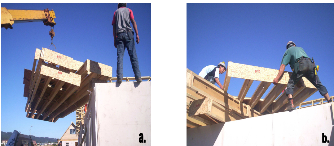
Fig. 5.45 a. Elevación del entramado de entrepiso al lugar de montaje con la utilización de una grúa b. Distribución del prefabricado en el entrepiso
