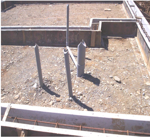
Fig. 5.15 Colocación de las instalaciones hidrosanitarias previo a la compactación del suelo, donde se apoya la plataforma de hormigón
