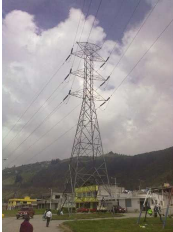
Figura 1.3 Torre de retención
