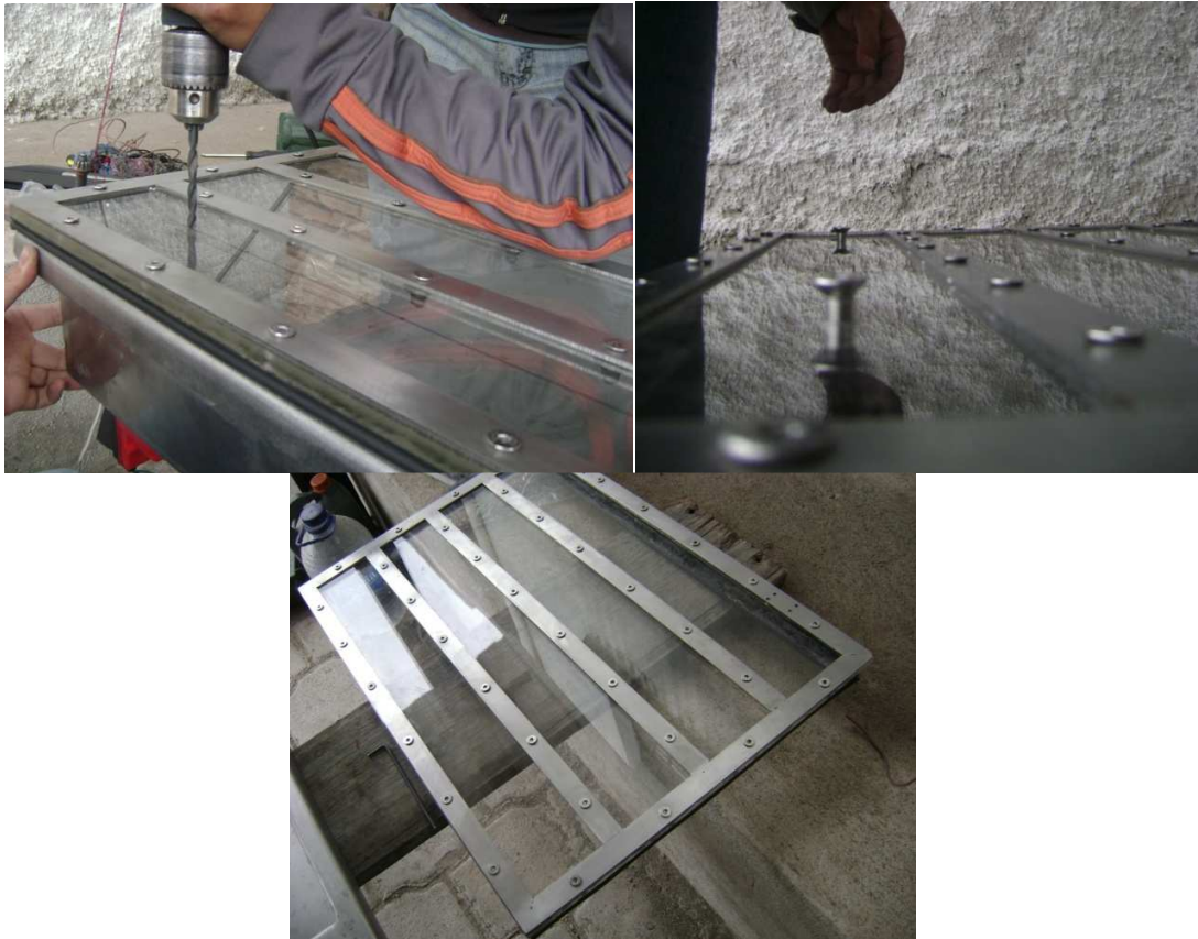
Figura 82 Construcción de la tapa para la cámara
