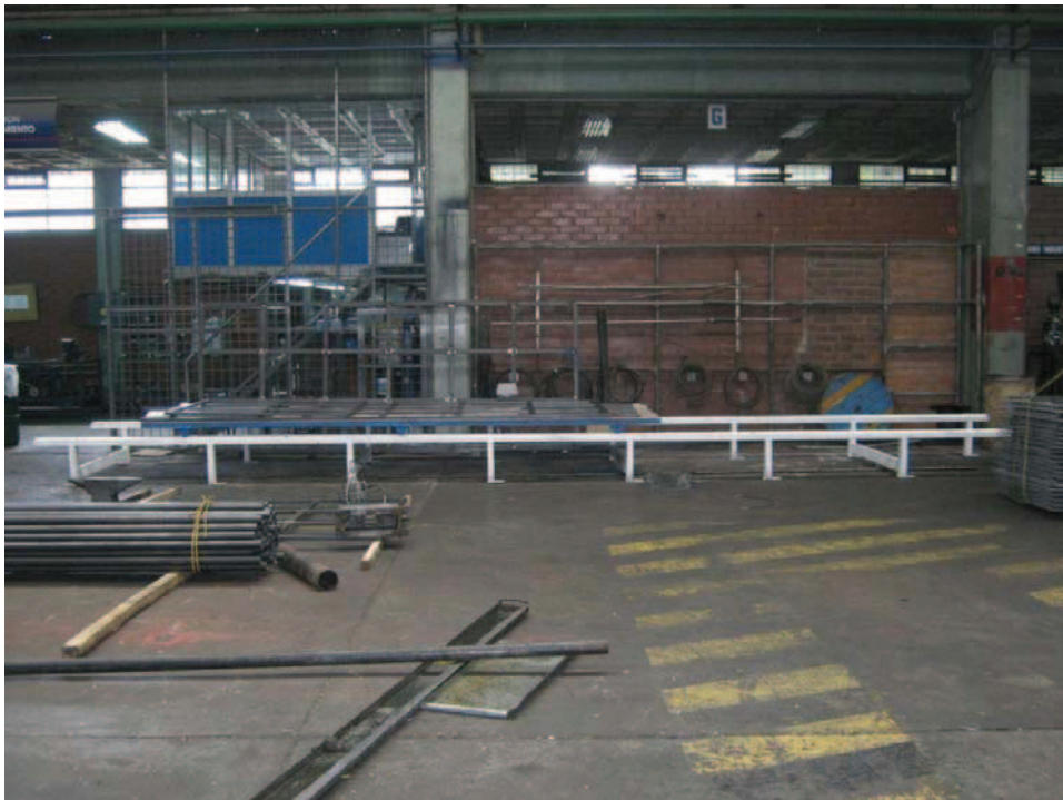
Figura 4.13 Foto de montaje de bastidor.
