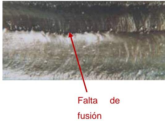
Figura 4.4 Fusión incompleta entre cordones de soldadura
