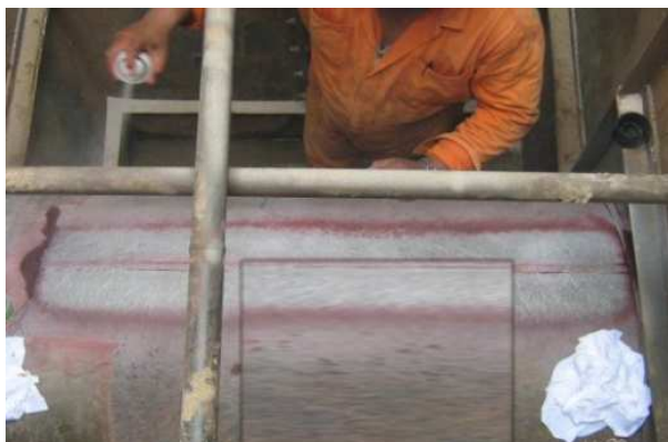
Figura 1.34 Aplicación del revelador
