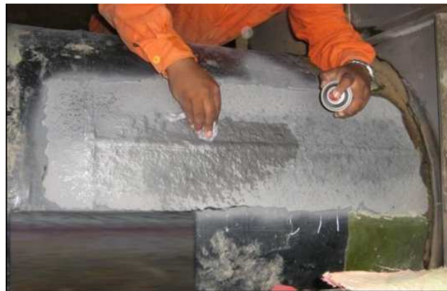
Figura 1.32 Limpieza mediante aplicación de líquido removedor
