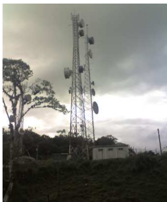
Figura 3.5: Estación Tres Cruces
