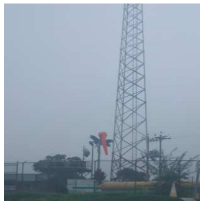
Figura 3.8: Estación Lago Agrio
