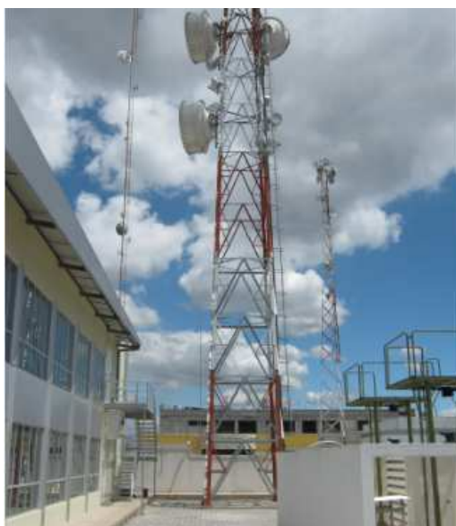
Figura 3.2: Estación Carretas - Quito
